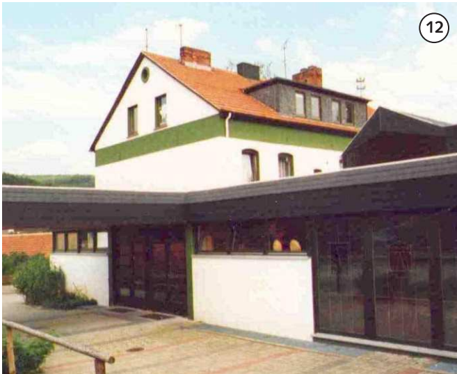
Auf dem Dach der ehemaligen Schule Eidengesäß (heute Dorfkrug und Bürgersaal) stehen mehrere Antennen. Heute sind die Antennen verschwunden, aber die Masten sind noch da.
