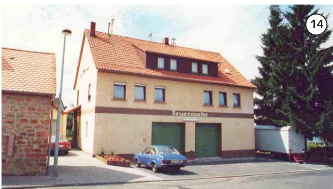
Auch auf dem Feuerwehrhaus in Eidengesäß sind neben Stromleitungen mehrere Antennen aufgebaut. Eine Sirene gibt es hier nicht, die steht auf dem Rathaus. Das Feuerwehrgebäude wurde 2021 abgerissen und ein Neubau hier errichtet.
