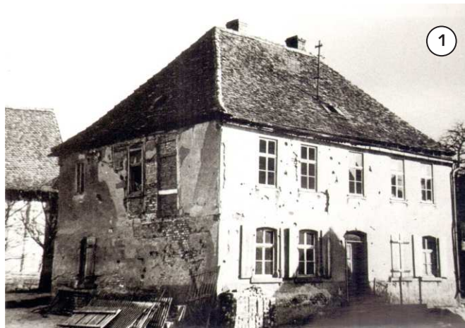
Das Lehrerhaus in der Schulstraße (später Florianstraße) Altenhaßlau. Auf dem Dach steht ein Mast für die Leitungen der Stromversorgung.
