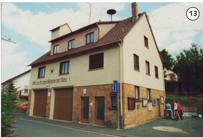
Nur schwer ist die Antenne auf dem Rathaus Lützelhausen zu erkennen. Der Fotograf konnte wohl nicht ahnen, dass dieses Detail einmal wichtig sein könnte. Die Sirene ist allerdings gut im Bild.
