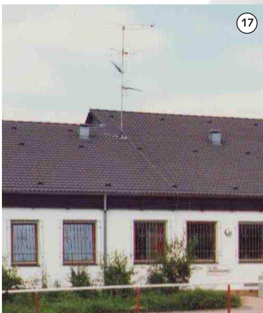
Die Antennen auf dem Dach des Sportheimes Großenhausen zeigen in verschiedene Richtungen, damit mehrere Programme empfangen werden können.
