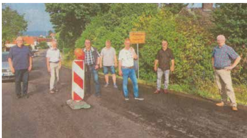
Herbert Bien, Bodo Delhey, Manfred Kapp, Torsten Gast, Carsten Kauck, Christian Clauss und Heinz Breitenbach (von links) machen sich ein Bild vom Baufortschritt an der Kreisstraße 897.
