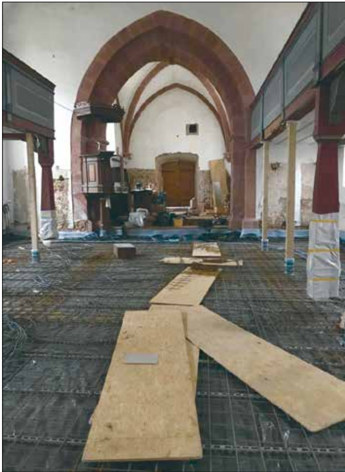
Der Grundaufbau für den neuen Fußboden.
